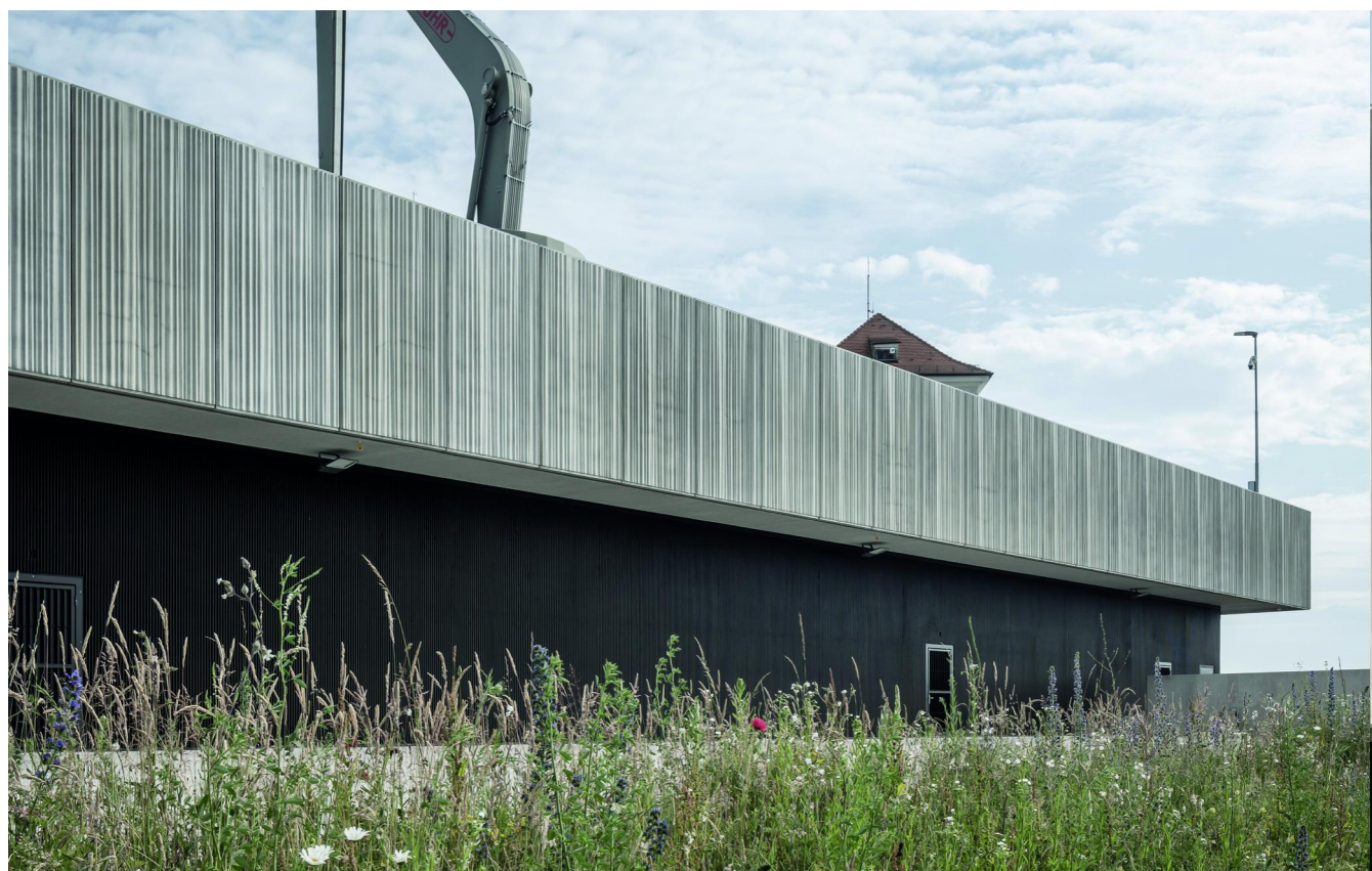
Einlaufbauwerk © Rainer Taepper
