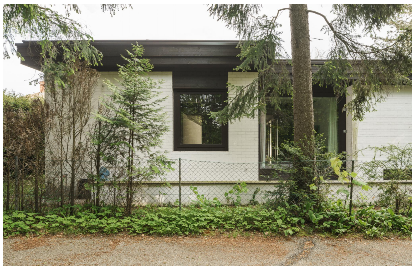
Dach und Fensterdetail © Benjamin Eder
