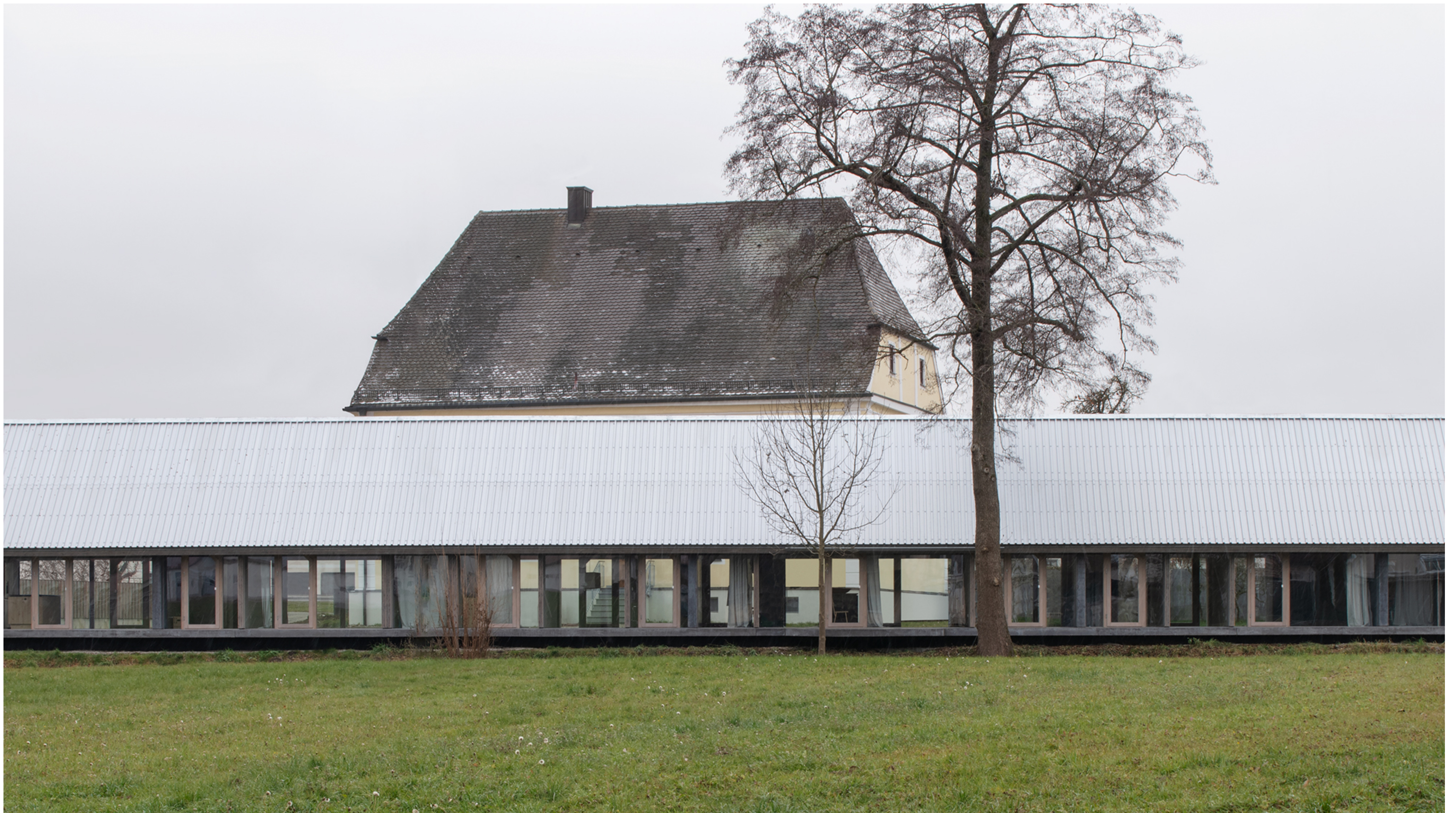
Neubau und Bestand © Mikael Olsson
