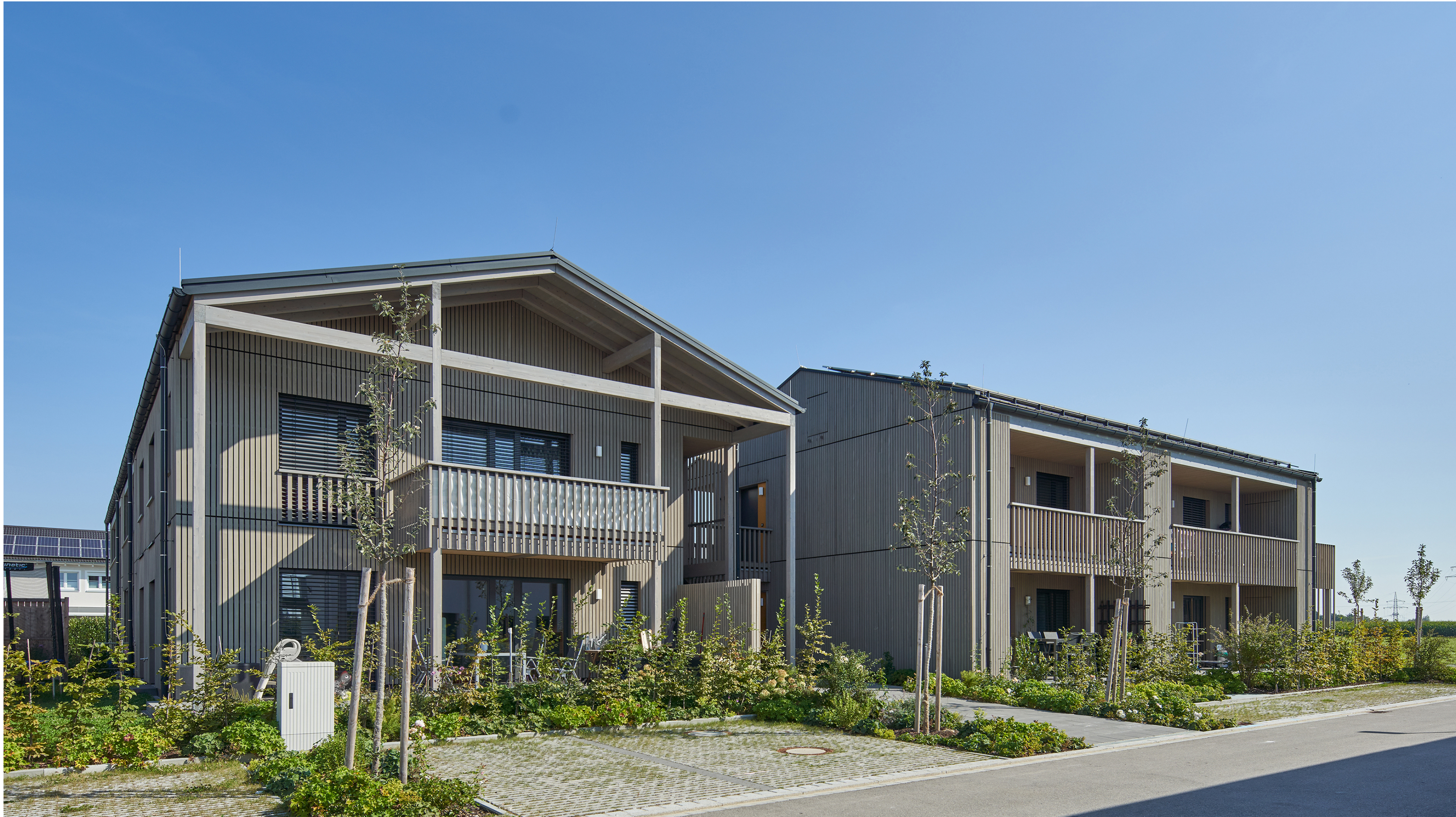
Südansicht © Jens Weber, Connolly Weber Photography - München
