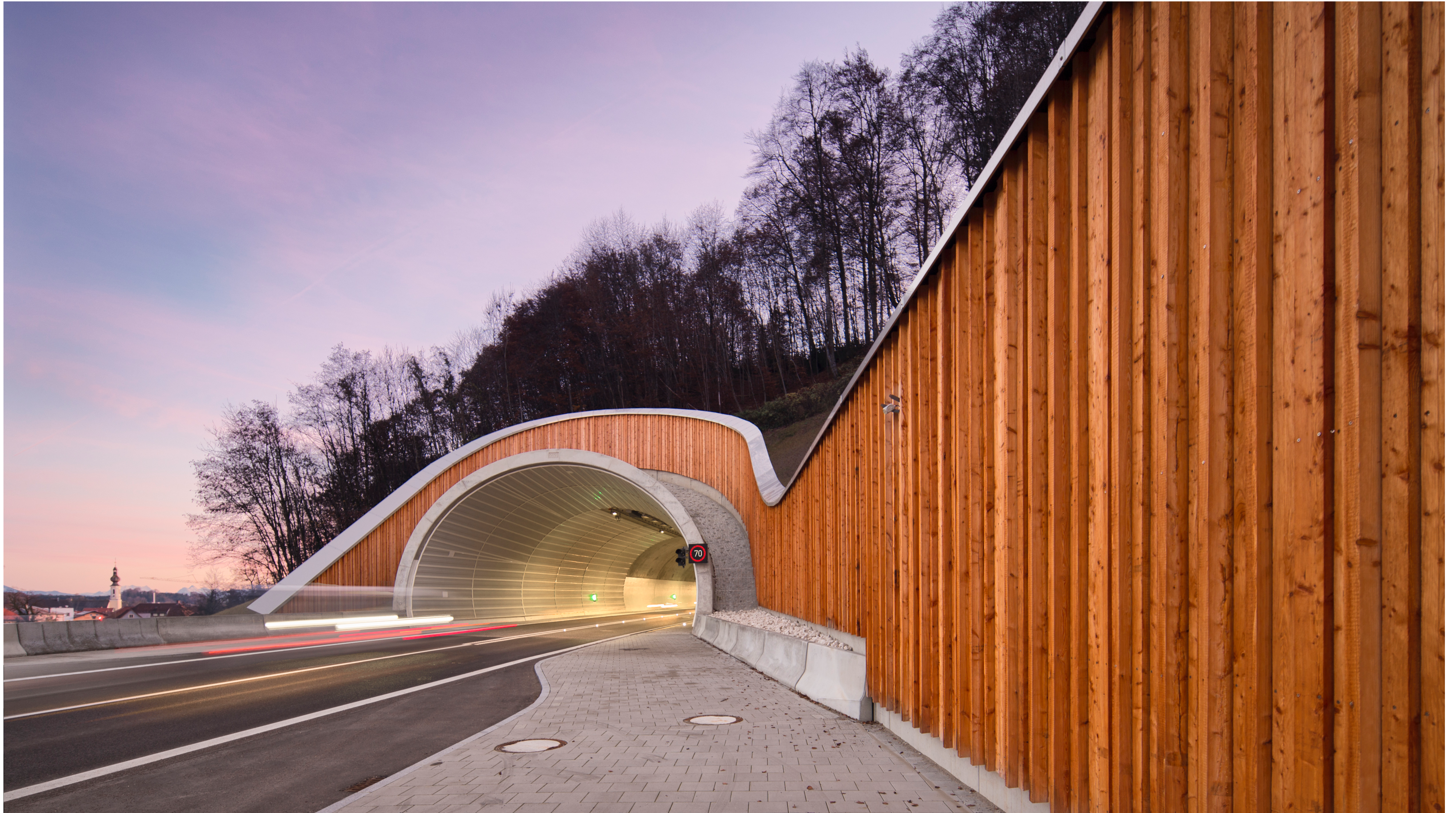
Nordportal © Lechner · Lechner Architekten
