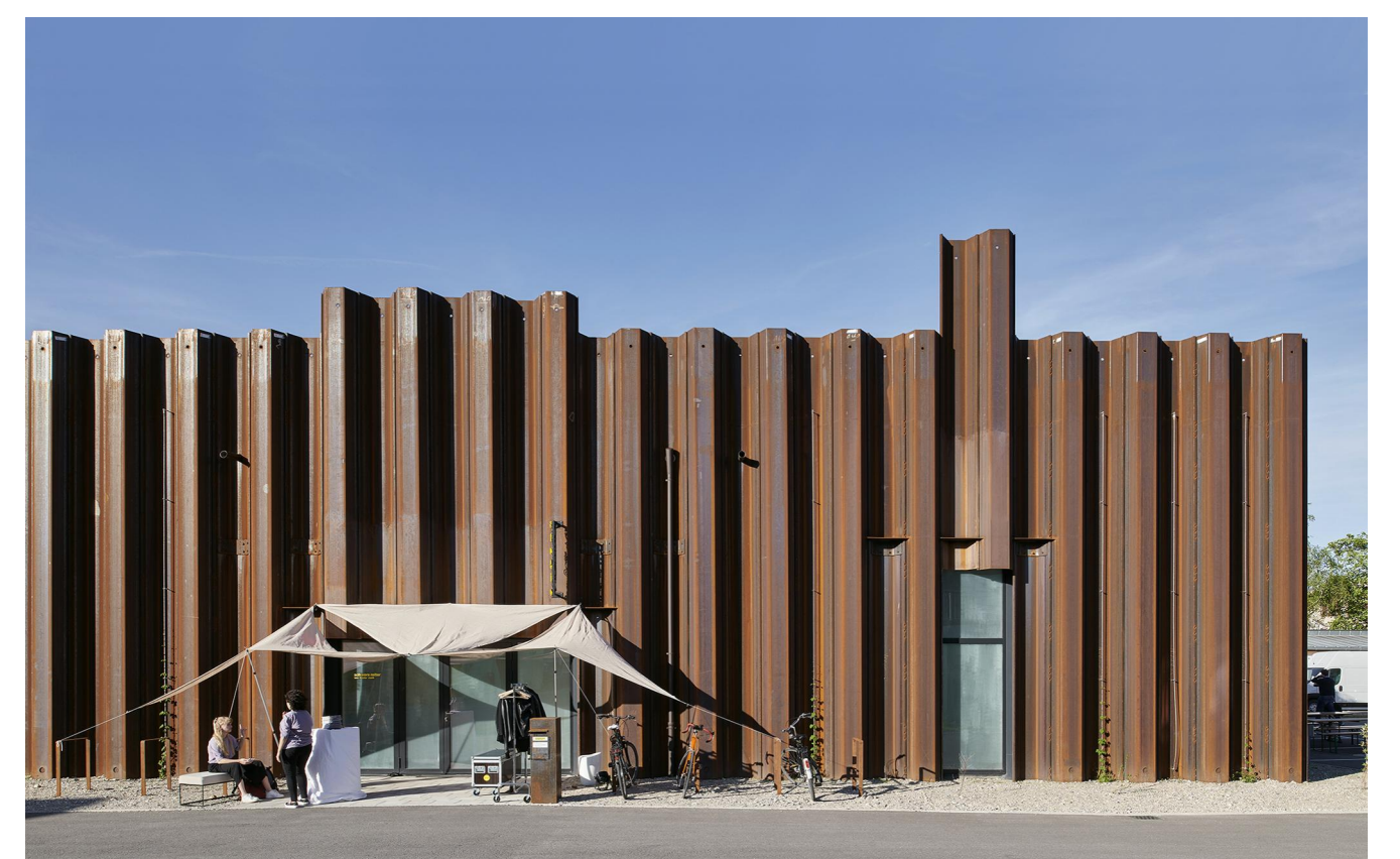
Fassadenansicht Kulturzentrum, Kreativquartier © Oliver Jaist
