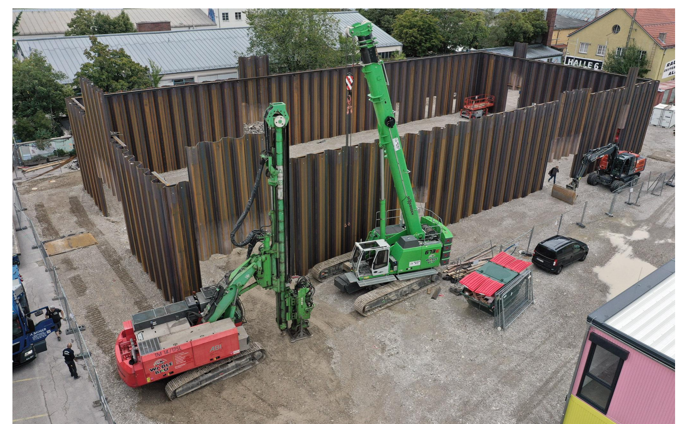
Bauphase © Wadle Bauunternehmung GmbH
