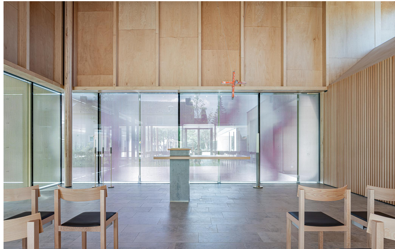
Transluzente Rückwand - sichtbare Tragwerkstruktur © Maximilian Gottwald
