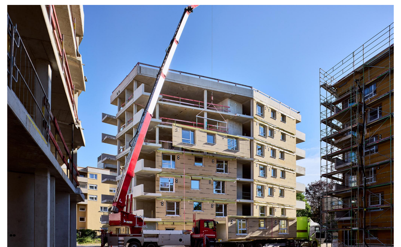
Montage der Holzelementfassade © Jonathan Sage
